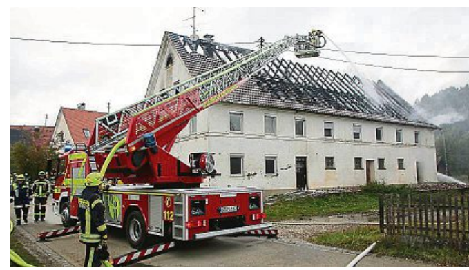
Schweißarbeiten verursachten einen Großbrand. F.: DPA/M. OBESER
